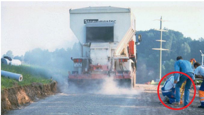
5. Zementverlegung: Der Zement wird gemäss Eignungsprüfung mittels Zementverlegegerät aufgebracht. Rechts: Eichvorgang.
