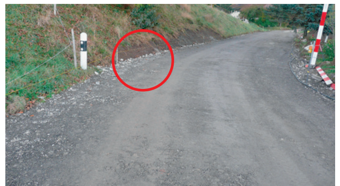
2. Vorprofilierung: Neues Strassenniveau nach der Aufkiesung. Die Schnur dient auch als Referenz für den Fundationsstabilisator.
