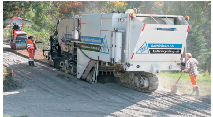
6. Kaltrecycling: Brechfräsen bis 40 cm Tiefe, Vermischen von Zement, evtl. Bitumenemulsion und Wasser samt Grobeinbau. Hinten: Vorverdichtung als Vorbereitung für Grader.
