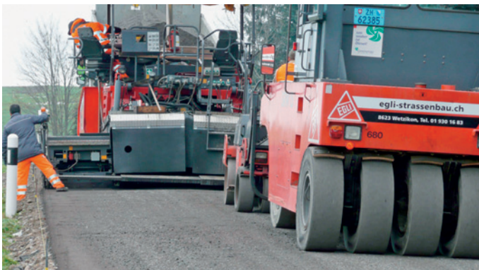
15. Mineralische SAMI: Gegen die Rissbildung wird eine 2–3 cm starke mineralische SAMI (spannungsabsorbierende Zwischenschicht) aus Feinkies eingebaut.
