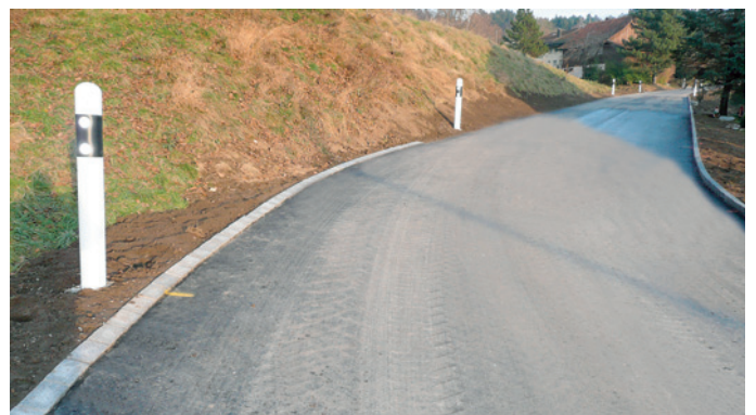
18. Fertige Strasse: Die neue Strasse ist etwas verbreitert, teilweise neu profiliert und deren Tragfähigkeit ist verdoppelt. Kostengünstig und umweltfreundlich.
