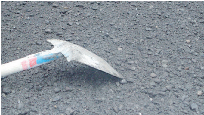
13. Abgestufte Kornverteilung: Dank Brechfräsen (Fräsen von oben nach unten) ergibt sich ein homogenes, gut verdichtbares Mischgut.
