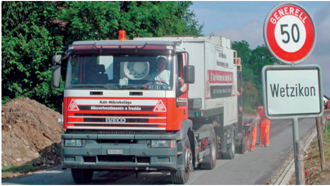
3. Sandverlegung: Bei sehr «scharfem», d.h. sehr grob brechen dem Altasphalt muss gemäss Eignungsprüfung evtl. Sand vorgelegt werden.
