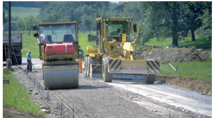
14. Feinplanie durch Grader: Endverdichtung mit schweren Walzen. Unter Umständen genügt darüber eine OB als Verschleisschutz.
