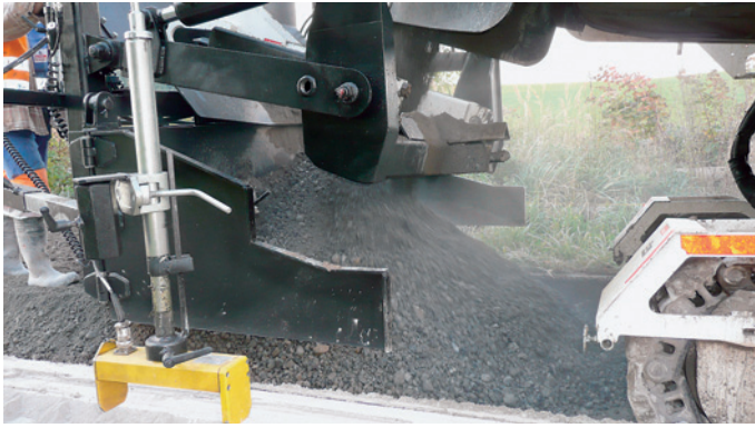
11. Mischgutüberwurf: Das gebrochene und mit Bindemittel versetzte Mischgut gelangt in das Einbaugerät hinter der Maschine.
