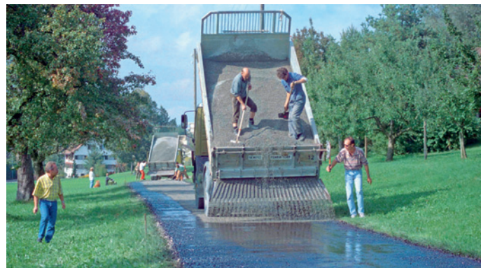
16. Bituminöse SAMI: Die SAMI (Stress-Absorbierende Membran Interlayer) kann auch durch eine Oberflächenbehandlung erfolgen.
