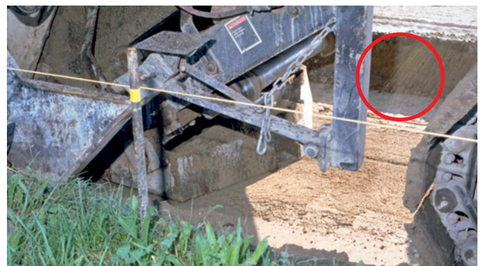
10. Sichtbarer Untergrund: Da das ausgefräste Material vom Boden abgehoben wird, kann der Untergrund jederzeit eingesehen werden.
