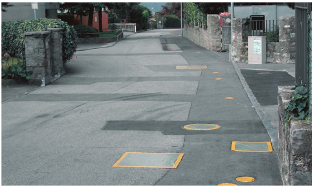
5. Abdecken 2: Die saubere Abdeckung der Schächte verhindert das Einfließen der Emulsion zwischen Schachtdeckel und Schachtringe respektive ein Verkleben derselben.
