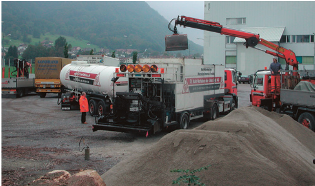
7. Installation: In der Nähe der Einbaustelle(n) muss ein Installationsplatz zur Verfügung stehen, wo Zuschlagstoffe und Bindemittel gelagert und geladen werden können.
