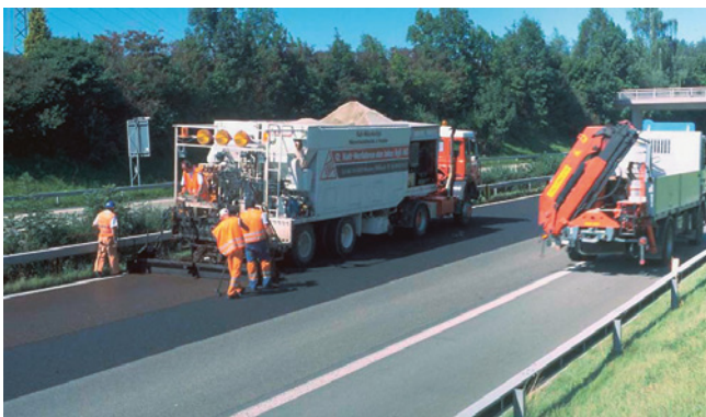
11. Autobahn: Autobahnen werden mit zwei Maschinenzügen und ohne Verkehrssperren durchgeführt. Rechts die unbehandelte Strasse, in der Mitte das Vorprofil und links die Deckschicht.
