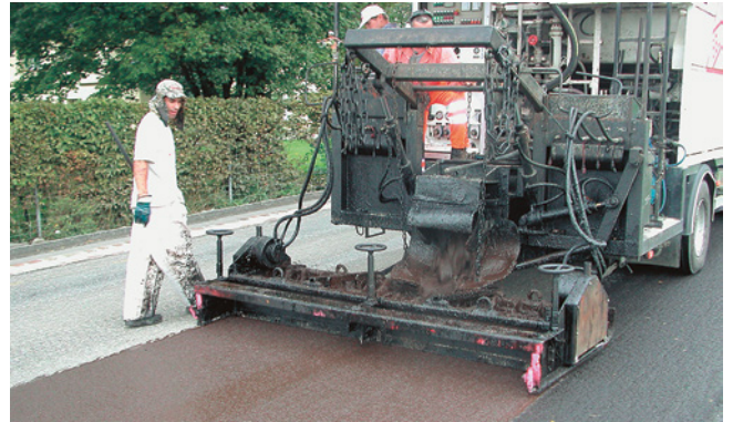
8. Verlegen: Ein Kaltmikrobelag ist nach dessen Herstellung breiig und von brauner Farbe. Wenige Minuten nach der Verlegung wechselt die Farbe auf schwarz als Zeichen dafür, dass die Emulsion gebrochen ist.
