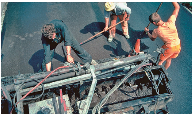
9. Verlegeschlitten: In festen oder extendierbaren Verlegeschlitten wird das aufbereitete Mischgut auf die gesamte Verlegebreite verteilt, dauernd in Bewegung gehalten und in definierter Stärke verlegt.
