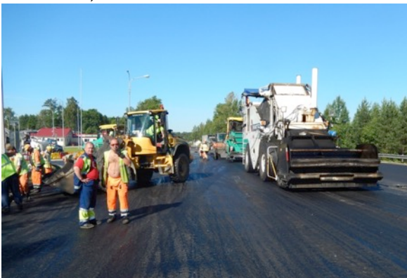
440'000 m 2 Belag abfräsen und zweischichtig wieder einbauen
